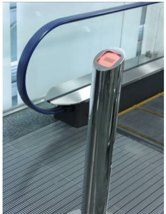
倒れ検知システムの施工例
