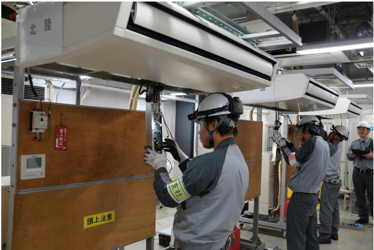
修理(空調機運転診断)
