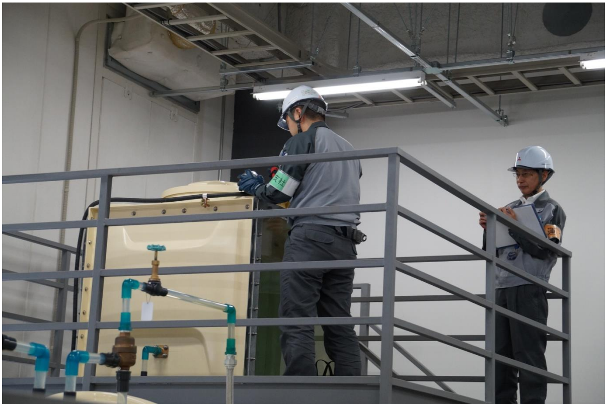
保守 I (給水設備診断及び復旧・操作)
