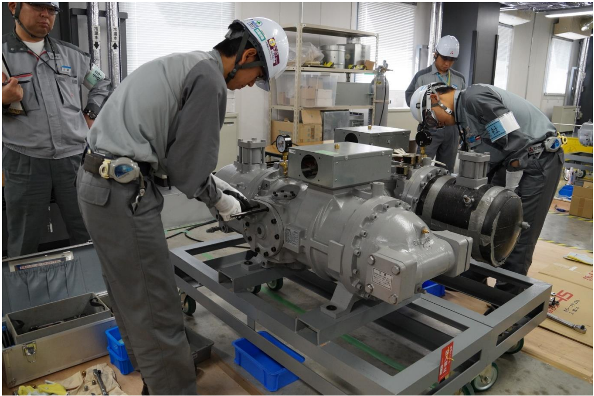
整備 I (圧縮機オーバーホール)
