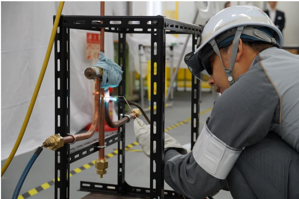
整備Ⅱ(四方弁 溶接)
