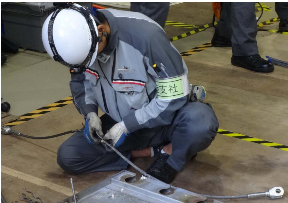
機能維持修理 I (新旧のロープ接続とロープ端末処理)
