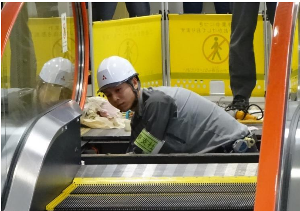
エスカレーター保全 (機械室の駆動機、チェーン、制動機の点検)
