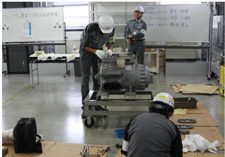
圧縮機整備（オーバーホール）
