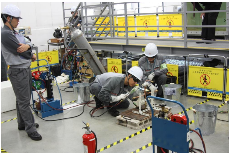
空調機整備（溶接作業）
