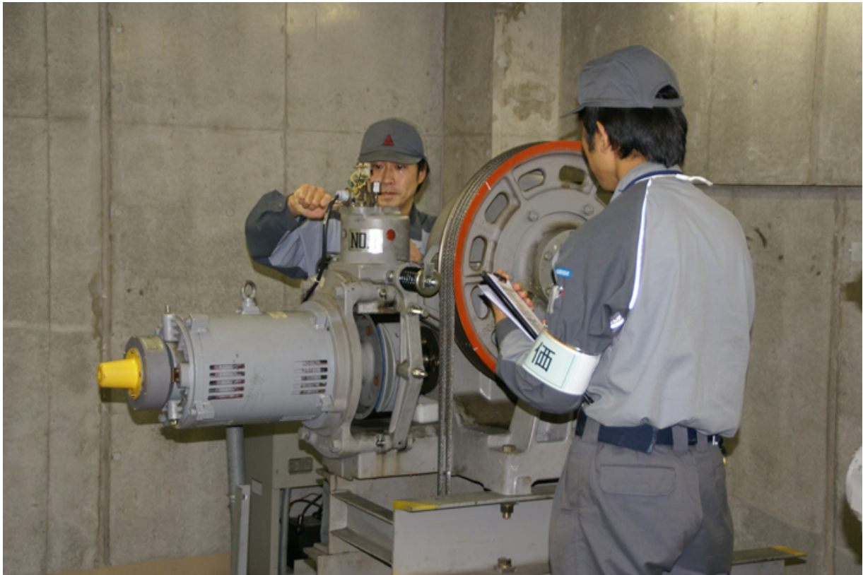
エレベーター保全作業
