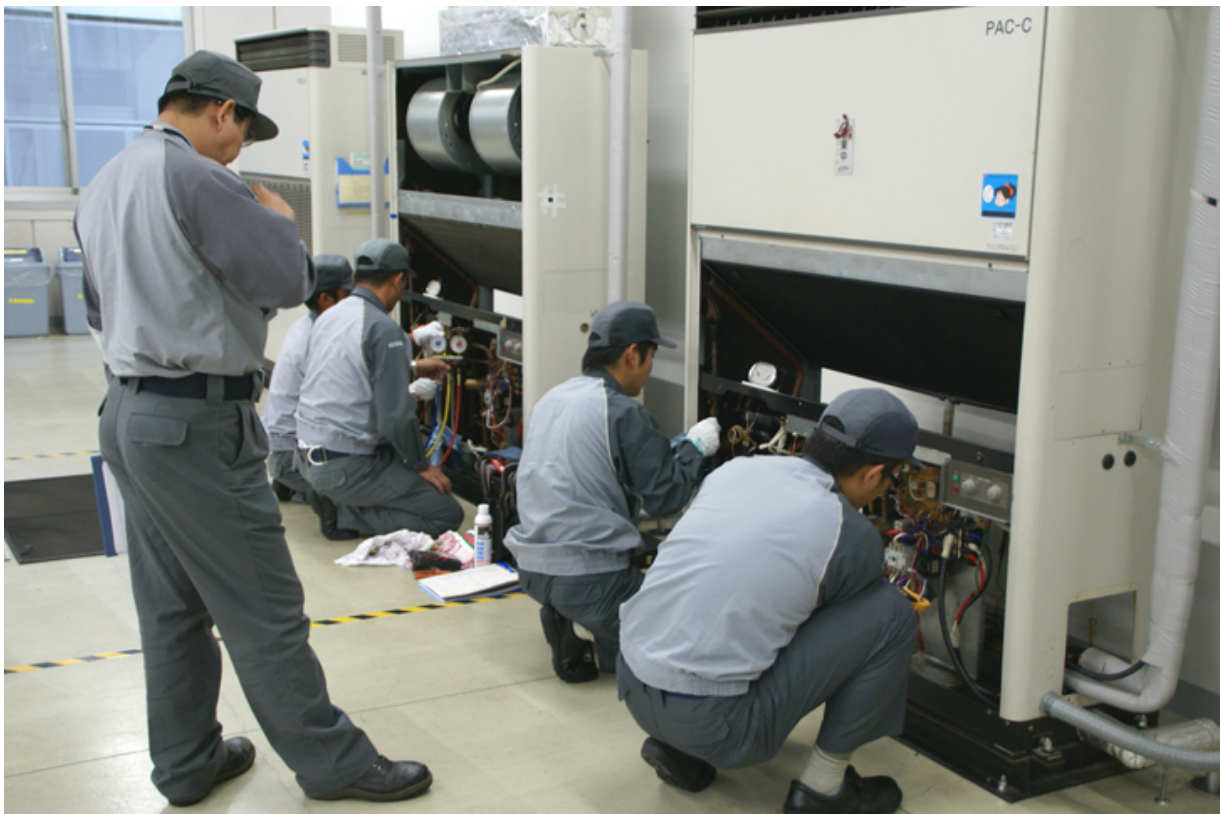
空調機保全作業
