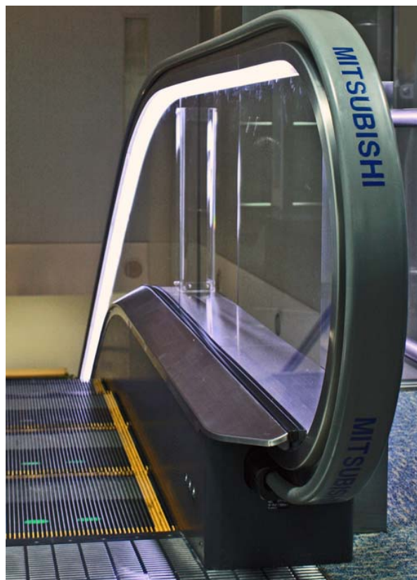
エスカレーター欄干照明のLED化工事の施工例
