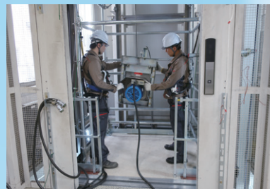
エレベーター据付実習
