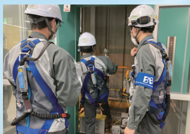
エレベーター保守実習
